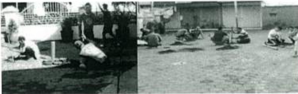
Gambar 5.6. Pemasangan tabung biopori dibantu dengan linggis karena alat bor masih terbatas
