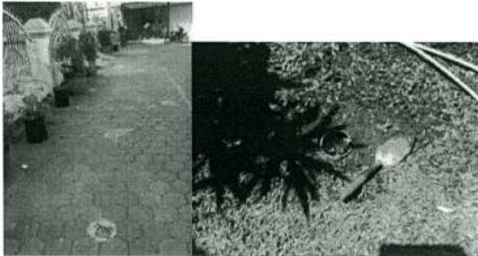
Gambar 5.9. Kondisi lubang biopori dan sudah difungsikan dengan baik
