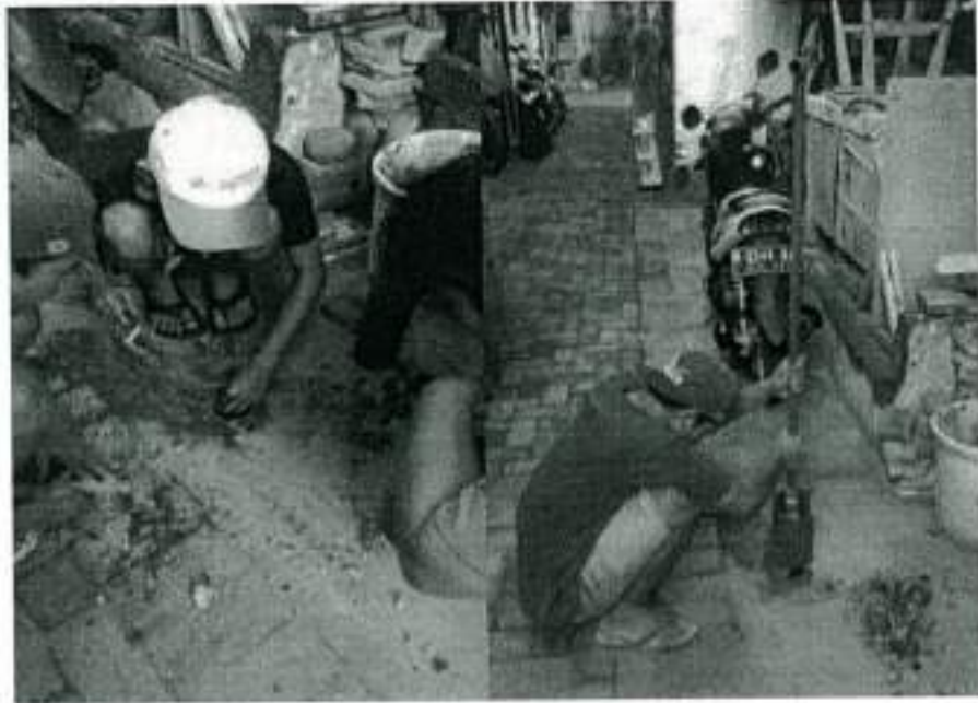
Gambar 5.8. Pemasangan tabung biopori tahap 2
